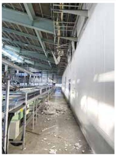
選果ラインのずれや天井・壁の一部崩落が確認されたトマト選果場
