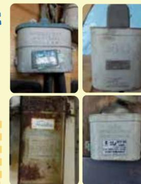
低圧進相コンデンサーとは? 畜舎や作業場の動力設備、農家の乾燥用モーター、揚水ポンプ等の電気機器の効率を改善する目的で、壁や配電盤などに設置されている電気機器です。
