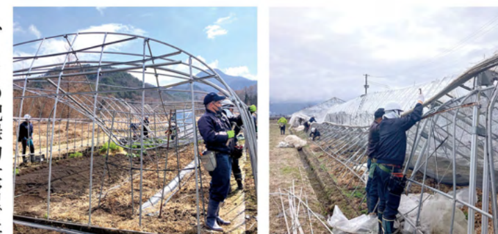
被害を受けた農業ハウスの解体作業に当たる当JAの職員ら
